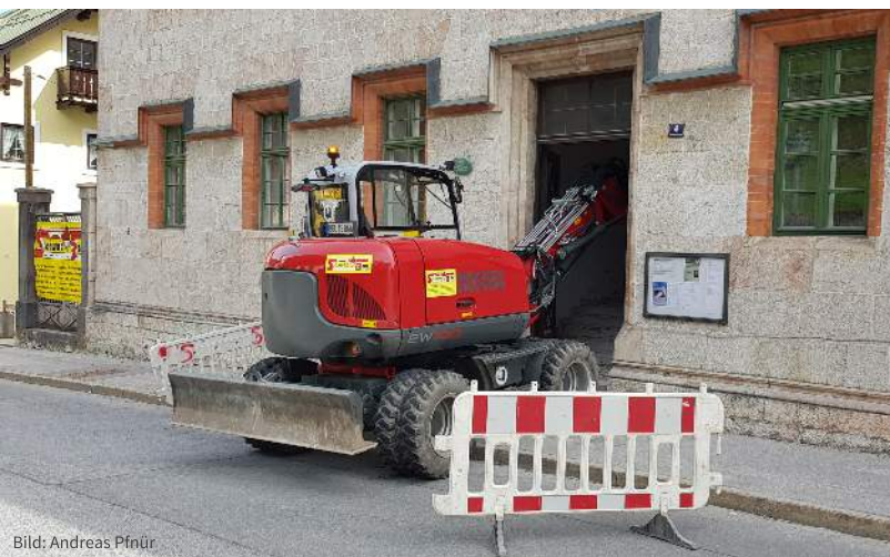
Bild: Die Unterhaltskosten für die Liegenschaften, wie hier die Sanierung des Pfarrhauses in Berchtesgaden, sind ein großer Ausgabeposten.
